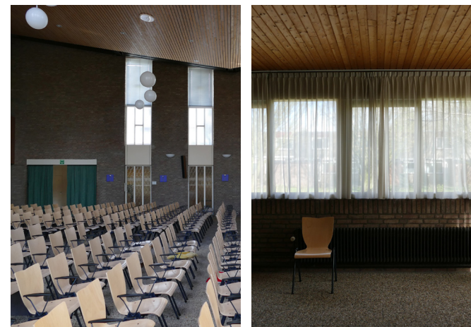
Situatie voor de verbouwing. Grindtegels, schrootjes, donker metselwerk en vitrage domineerden het beeld.
